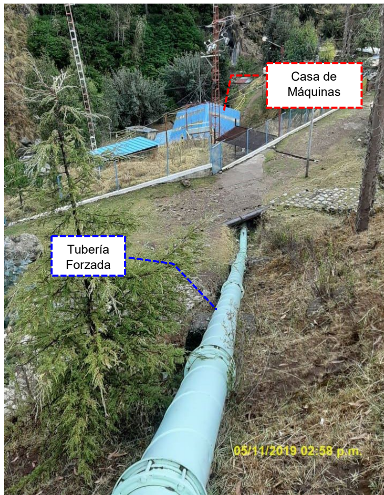
Fotografía N° 02: Vista Panorámica – Casa de Máquinas
