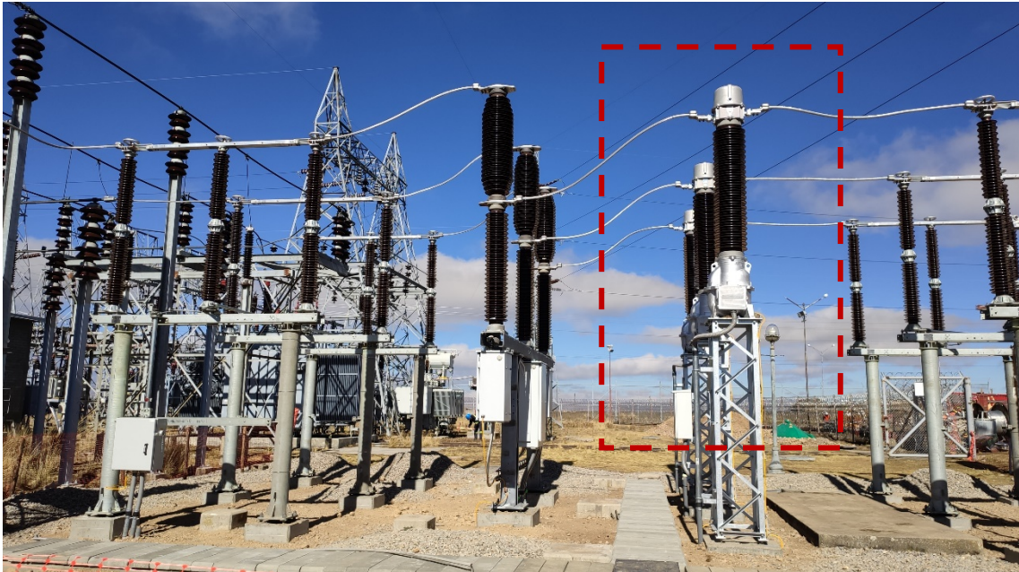
Fotografía N°02: Transformadores de Corriente
